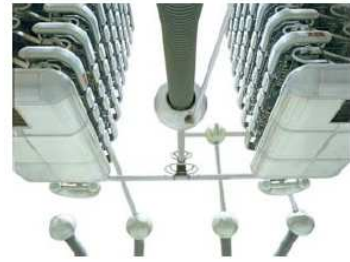
Figura 25.13. Um sistema DC de alta potência na China. Foto ABB.
