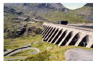
Figura 26.6. Llyn Stwlan, o reservatório mais alto do sistema de armazenamento bombeado no norte do País de Gales. Energia armazenada: 1,3 GWh. Foto de Adrian Pingstone.
