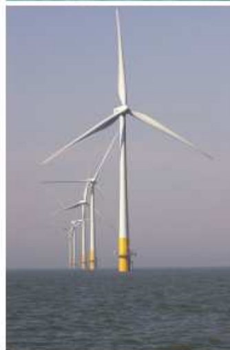
Figura 10.1 Kentish Flats – um parque eólico de ventos rasos. Cada rotor possui um diâmetro de 90 m centrados em um cubo a 70 m de altura. Cada turbina de “3 MW” pesa 500 toneladas, sendo que metade do peso é o seu fundamento.
