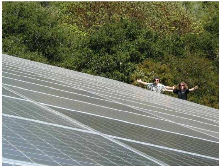
Figura 6.6. Dois guerreiros do sol aproveitando o seu sistema fotovoltaico, que alimenta seus carros elétricos e residência. A matriz de 120 painéis (300 W cada, 2,2 m 2 cada) possui uma área de 269 m 2 , uma saída de pico (permitindo por perdas de conversão DC-AC) de 30,5 kW, e uma saída média – na Califórnia, perto de Santa Cruz – de 5 kW (19 W/m 2 ). Foto amavelmente fornecida por Kenneth Adelman. www.solarwarrior.com
