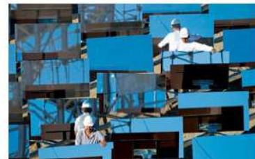
Figura 25.12. Dois engenheiros montando uma estação de potência de concentração eSolar utilizando heliostatos (espelhos que giram suas pontas para seguir o sol). eSolar.com produz estações de potência de média escala: uma unidade de potência de 33 MW (pico) em um local de 64 hectares. Isto são 51 W/m 2 de pico, então eu suporia que numa localidade típica de deserto eles forneceriam um quarto disto: 13 W/m 2 .
