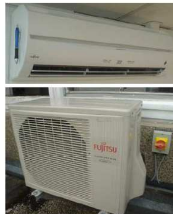
Figura 21.11. As partes de entrada e saída de uma bomba de calor de fonte de ar que possui um coeficiente de desempenho de 4. A parte de entrada é acompanhada por uma caneta esferográfica, como escala. Uma destas unidades Fujitsu pode fornecer 3,6 kW de aquecimento enquanto consome apenas 0,845 kW de eletricidade. Ela também pode funcionar ao contrário, fornecendo 2,6 kW de refrigeração quando consumindo 0,655 kW de eletricidade.
