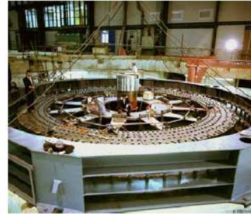
Figura 26.15. Um dos dois pêndulos na instalação de fusão em Culham, sob construção. Foto: EFDA-JET. www.jet.efda.org .
