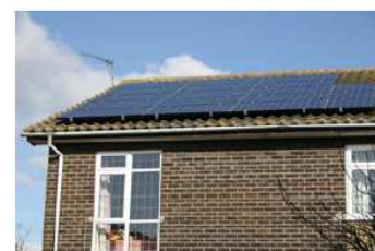
Figura 6.5. Solar fotovoltaica: dados das matrizes de 25 m 2 em Cambridgeshire em 2006. A potência de pico fornecida por essa matriz é cerca de 4 kW. A média, anual, é de 12 kWh por dia. Isto é 20 W por metro quadrado de painel.
