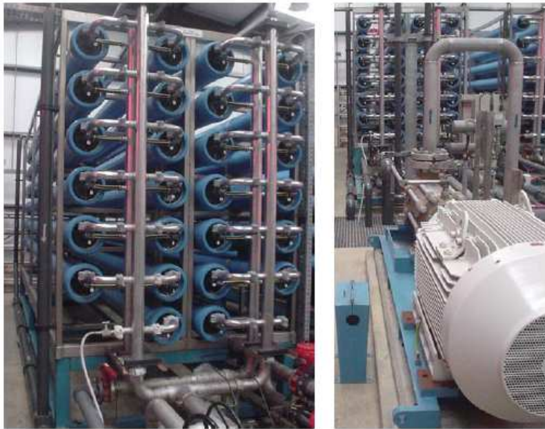
Figura 15.10. Parte da instalação de osmose reversa da planta de dessalinização de Jersey's Water. A bomba no primeiro plano, à direita, possui uma potência de 355 kW e empurra a água do mar a uma pressão de 65 bar em 39 membranas em espiral nos bancos dos tubos azuis horizontais, à esquerda, fornecendo 1500 m 3 por dia de água limpa. A água limpa desta instalação possui um custo energético total de 8 kWh por m 3 .
