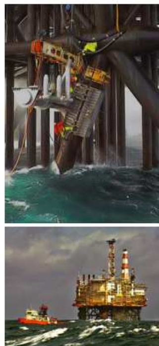
Figura 10.4. A plataforma Magnus no setor norte do Reino Unido no Mas Norte contém 71 000 toneladas de aço. No ano 2000 esta plataforma forneceu 3,8 milhões de toneladas de petróleo e gás – uma potência de 5 GW. A plataforma custou £1,1 bilhão. Fotos por Terry Caverner.
