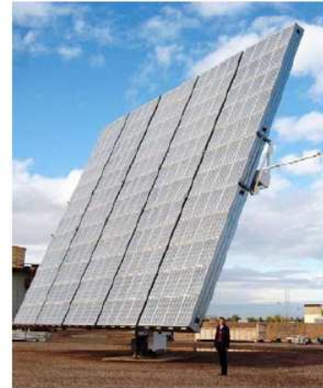
Figura 25.9. Um concentrador fotovoltaico de 25 kW (pico) produzido pela companhia californiana Amonix. Seus 225 \text{ m}^2 de abertura contém 5760 lentes Fresnel com concentração óptica de \times 260 , cada uma das quais ilumina uma célula de silício de 25% de eficiência. Um destes coletores, em uma localização apropriada de deserto, gera 138 kWh por dia - o suficiente para cobrir o consumo energético da metade de um americano. Observe a escala de fornecimento humana.
