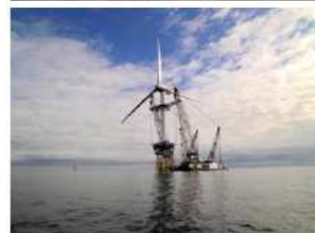
Figura 10.8. Construção do parque eólico de demonstração Beatrice. Fotos gentilmente cedidas pela Talisman Energy (UK) Limitada.
