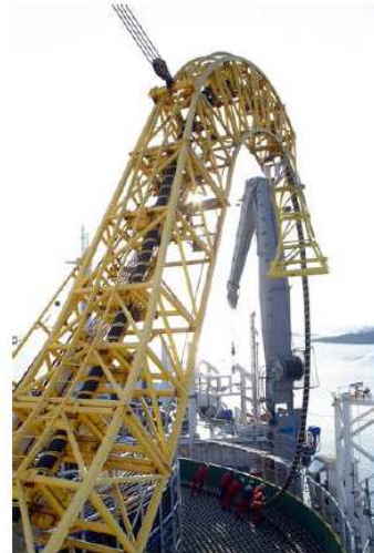
Figura 25.7. Colocando uma linha de alta tensão entre a Finlândia e a Estônia. Um par destes cabos transmite uma potência de 350 MW. Foto: ABB.
