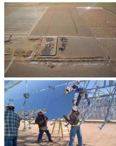
Figura 25.4. Andasol - uma estação de potência solar de "100 MW" em construção na Espanha. O excesso de energia térmica produzida durante o dia será armazenada em tanques de sal líquido por mais de sete horas, permitindo um fornecimento contínuo e estável de energia elétrica para a rede. Prevê-se que as estações de potência produzam 350 GWh por ano (40 MW). As calhas parabólicas ocupam 400 hectares, então a potência por unidade de terra será de 10 \text{ W/m}^2 .
