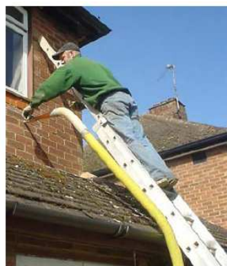
Figura 21.5. Preenchimento das cavidades da parede com isolante.
