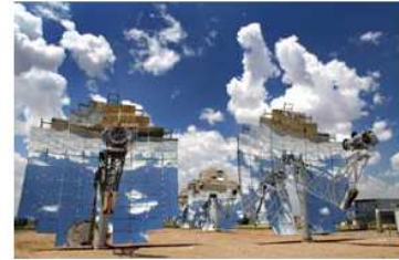
Figura 25.3. Motor Stirling. Estes belos concentradores fornecem uma potência por unidade de terra de 14 \text{ W/m}^2 . Foto cortesia do Sistema de Energia Stirling.
