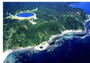
Figura 26.11. A estação de potência com armazenamento bombeado Okinawa, cujo reservatório baixo é o oceano. Energia armazenada: 0,2 GWh. Foto cortesia de J-Power. www.ieahydro.org .
