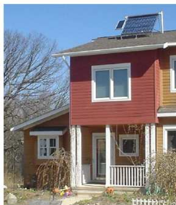
Figura 30.2. Um aquecedor solar de água fornecendo água quente para uma família em Michigan. A bomba do sistema é alimentada por um pequeno painel fotovoltaico à esquerda.
